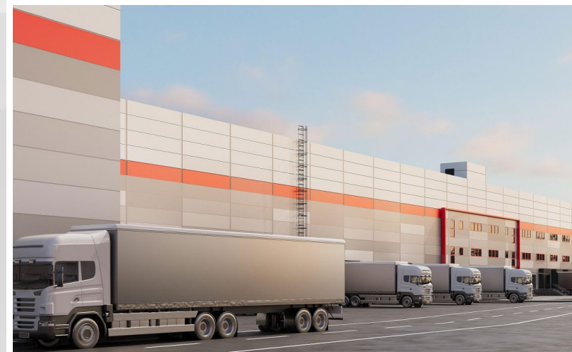
Складское здание в Молжаниновском р-не Проектировщик: ООО «АФА ПРОДЖЕКТ» Источник: afapro.ru – сайт ПБ «АФА-Проджект»
