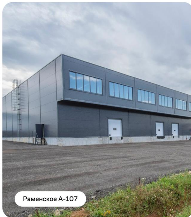
Здание упрощенного конструктива
